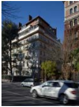
31 GINO BECKER: AUFSTOCKUNG, TURIN, 1955–62
