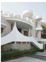
60 MARIO GALVAGNI CASA GIANOGGIO, TORRE DEL MARE, 1958
