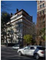
44 GINO BECKER AUFSTOCKUNG, TURIN, 1955–62
